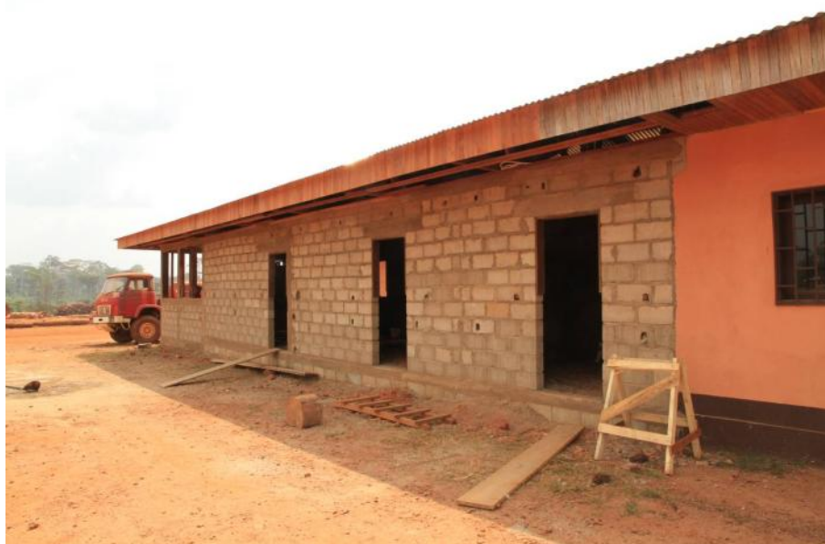
Laboratoire en construction sur le site de la Pallisco. © JL. Doucet
